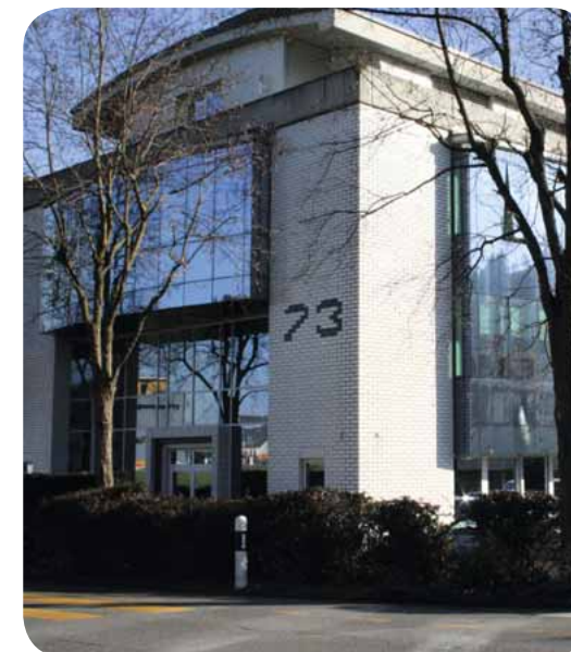
Die AUTOonline Schweiz AG Firmenzentrale in Pfäffikon.
